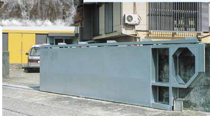
●尾鷲市大曾根浦漁港(尾鷲市役所) アルミ製横引きゲート 5.00m×1.50m
