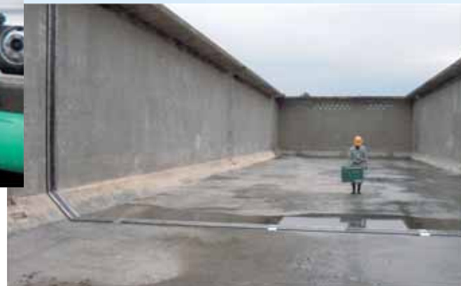
●多気郡多気町相可(三重県企業庁) 沈殿池 耐震目地設置 上流側(L=19.9m) 下流側(L=19.6m) 各2箇所
