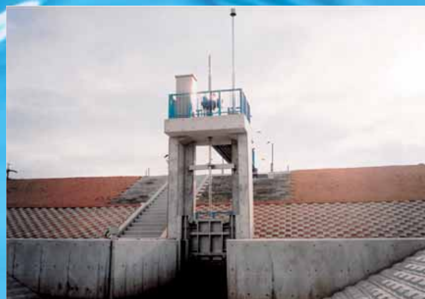
●揖斐川城之堀排水機樋管(国土交通省) ステンレス製ローラーゲート 1.6m×1.6m
