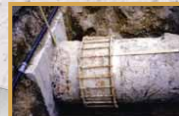
▼PC管丸ゴム飛び出しの漏水
