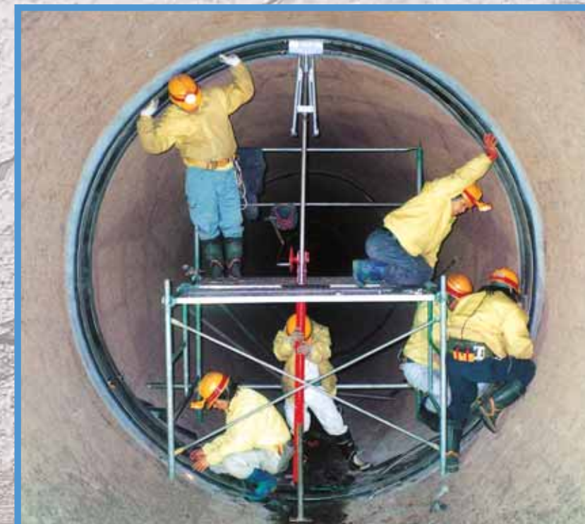
▼φ3,350mm管 内面バンド取付工事
