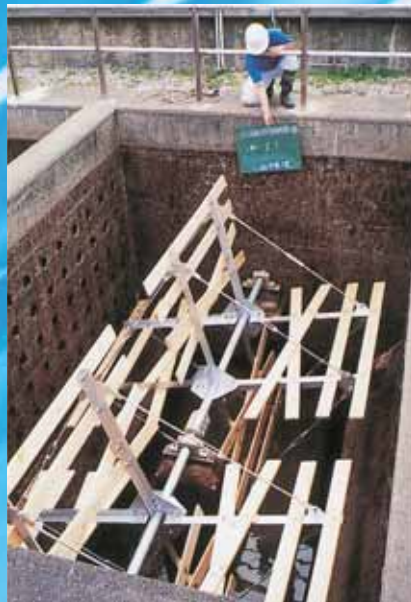
●志摩水道事務所(三重県企業庁) フロキュレータ(翼車)
