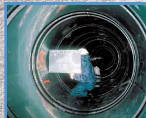
▼φ1,000mm管 内面バンド取付完了
