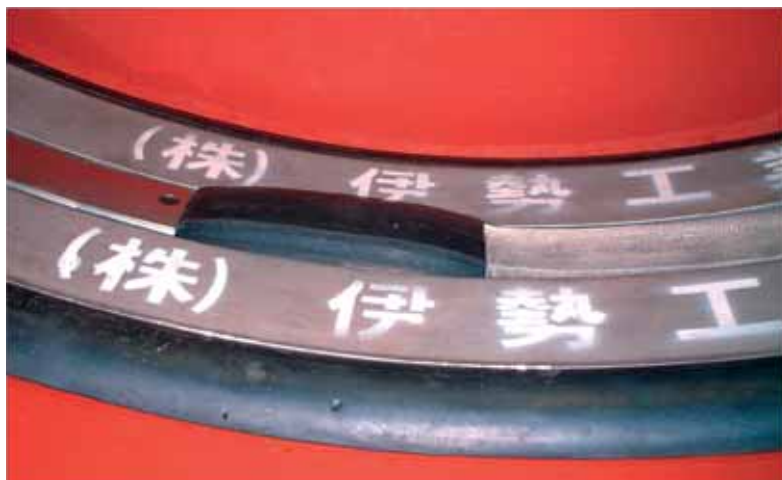
外水圧0.3MPaのゴムと外圧抵抗板
