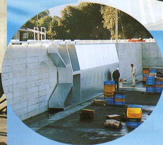
●天竜川北鹿島第2陸開 （国土交通省） 銅製プレートガータ式 スイングゲート 3.5m×1.3m
