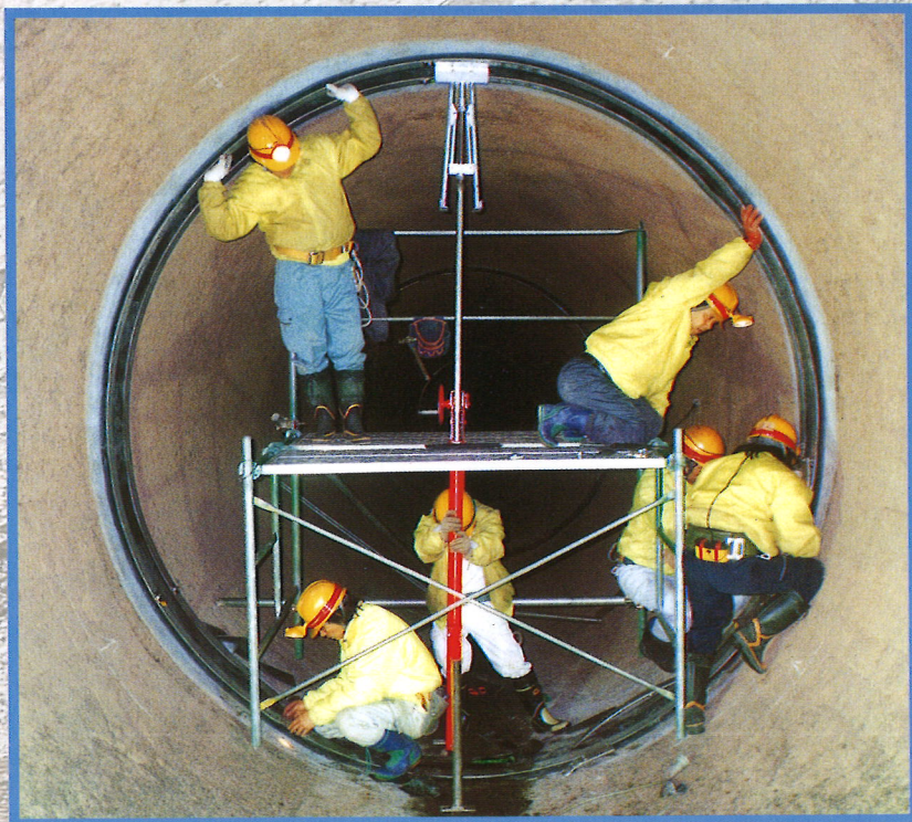
▼φ3,350mm管 内面バンド取付工事
