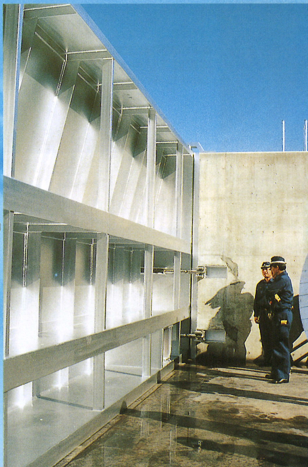
●尾鷲市大曾根浦漁港（尾鷲市役所） ステンレス/アルミ製横引きゲート 10.0m×3.6m
