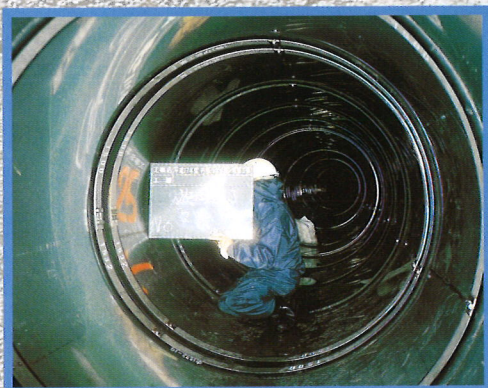
▼φ1,000mm管 内面バンド取付完了
