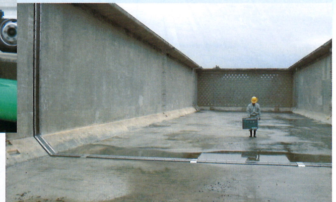
●多気郡多気町相可(三重県企業庁) 沈澱池 耐震目地設置 上流側(L=19.9m) 下流側(L=19.6m) 各2箇所
