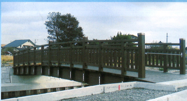
●桑名市長島町大字松ヶ島 (桑名農政環境事務所) 木製床版 人道橋上 13.3m×2.0m
